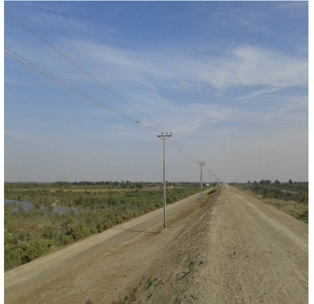
Picture 2: View of BU Bund (Land side)
